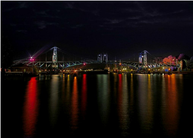
Die K-W-Brücke erstrahlt im neuen Glanz
